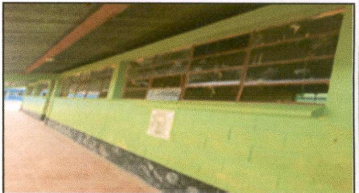
Foto 4: Estado actual de las ventanas sin balcones
