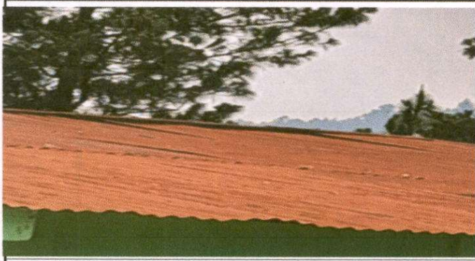
Foto 1: Estado actual del tejado
