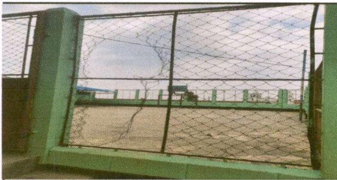
Foto 5: Estado actual del cerco perimetral
